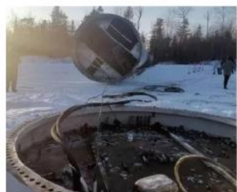
锚栓断裂现场图
