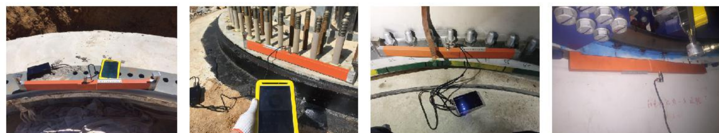
基础环水平度测试 锚栓基础法兰环水平度测试 塔底不均匀沉降测试 塔顶垂直度测试
